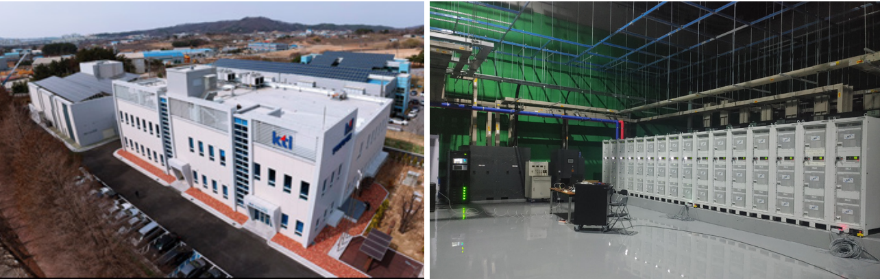
ESS 시험소 및 2.4MW급 PCS 시험 장비
